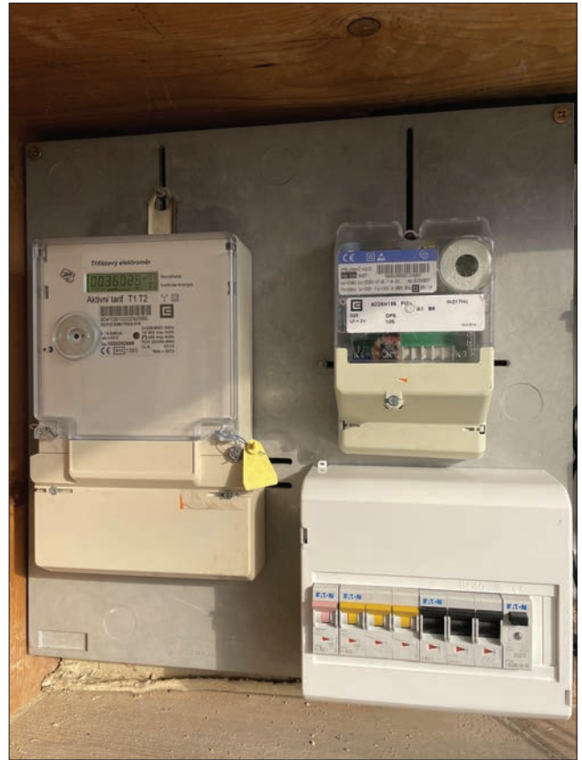
Obr. 26 Elektroměrová deska v původním stavu (vlevo) a rekonstruovaná elektroměrová deska upravená dle přípojovacích podmínek ČEZ pro výroby, připravená pro výměnu elektroměru a HDO.
